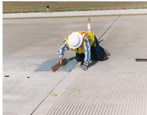
圖 3.2-10 部分深度修復(區塊修補)
