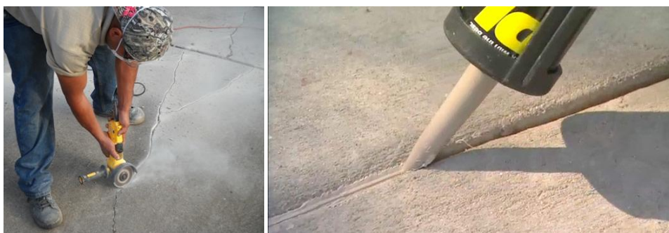
圖 3.2-4 裂縫填縫
