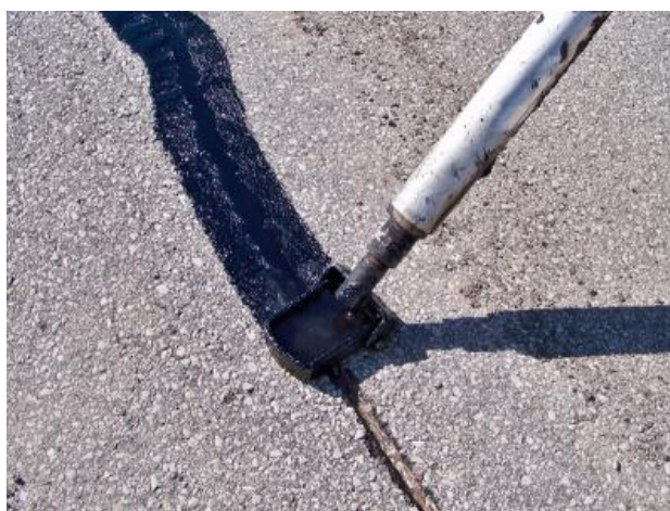
圖 2.2-1 裂縫填縫
