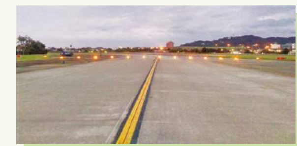
增設松山機場 10 跑道 B 型警戒燈 Adding Configuration B runway guard lights for Runway 10 in Songshan Airport
