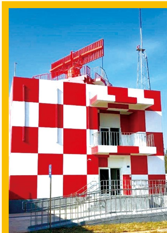
金門雷達機房新建工程 Construction of Kinmen ATC radar shelter
