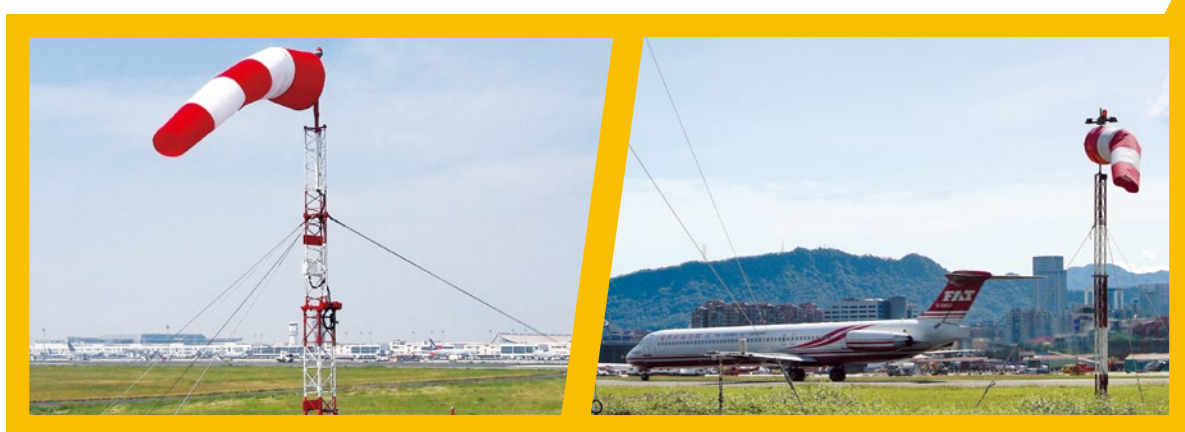
桃園機場及松山機場 AWOS AWOS in Taoyuan International Airport and Songshan Airport
